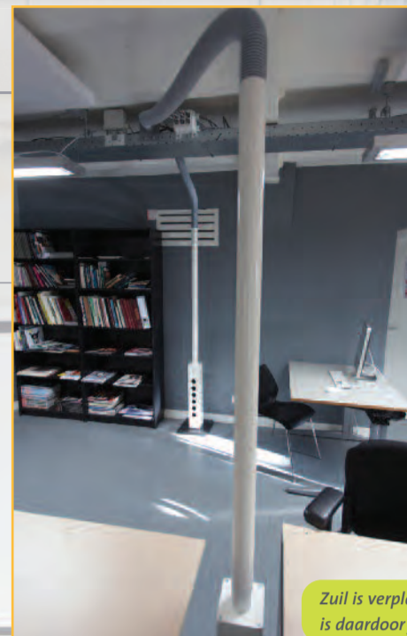
Speciale montagebeugel voor aansluiting op kabelgoot
