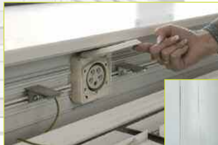
Klapgoot met speciale oplossing voor CEE contactdoos
