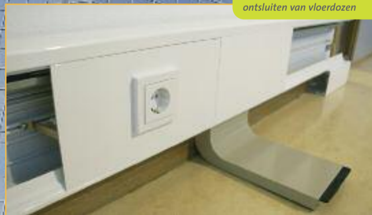
Speciale gebogen afdekgoot voor het ontsluiten van vloerdozen
